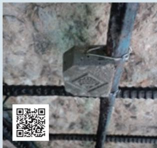
高品質な亜鉛のインゴットによって、長期間、継続的に防食電流を供給可能な犠牲陽極材です。ユニークなV字形の切り込みのある形状により、様々な鉄筋にも容易かつ正確に設置可能です。
