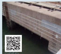
コンクリート表面に設置したチタンメッシュ陽極からコンクリート内部の鉄筋に防食電流を供給することで、鉄筋に生じる腐食電池を完全に消滅させることのできる最も信頼性の高い防食工法です。
