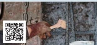
アクリル樹脂を用いたコンクリート下地用プライマーです。コンクリートに浸透し、吸水防止作用、接着増強作用に優れます。
