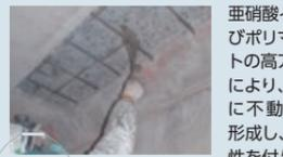
亜硝酸イオンおよびポリマーセメントの高アルカリ性により、鉄筋表面に不動態被膜を形成し、高い防錆性を付与します。
