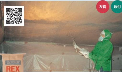
左官・吹付け両用の汎用型ポリマーセメントモルタルです。亜硝酸リチウム混入により、防錆モルタルとしても使用可能です。
