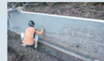
摩耗で劣化した農水路を補修するポリマーセメントモルタルです。
