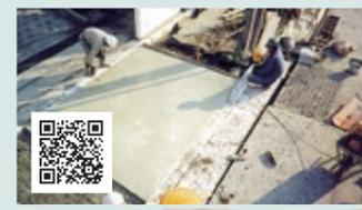
硬化時間が60分に調整された超速硬コンクリート用セメントです。
