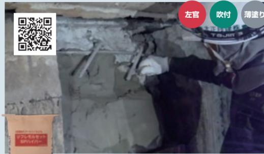
左官・吹付け両用の汎用・厚付け型ポリマーセメントモルタルです。亜硝酸リチウム混入により、防錆モルタルとしても使用可能です。t=2mmからの薄塗りにも適用可能です。
